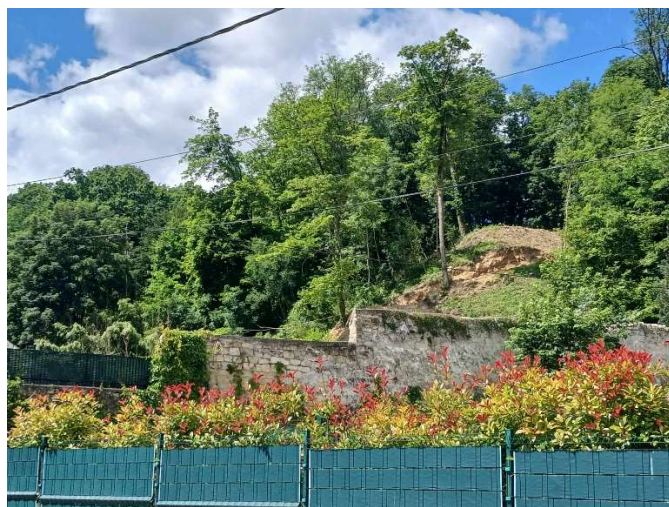
Photographie du site
